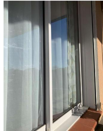
Les poignées de porte peuvent être un obstacle à la mise en place du FlowStop également. Veillez à les prendre en compte, elles peuvent nécessiter d'avoir un dispositif moins large ou avec une hauteur moins importante pour pouvoir s'installer convenablement.
