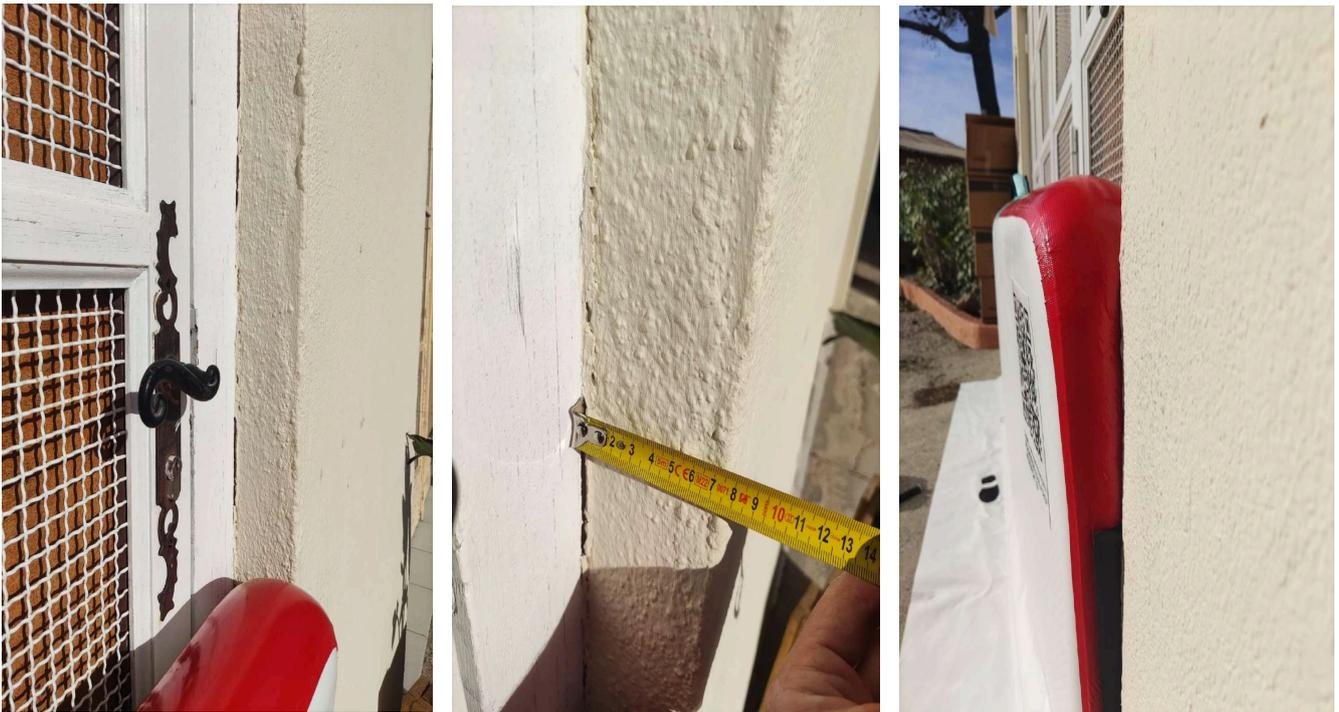
La pression exercée du FloxStop, sur le mur, empêche le dispositif de sortir de l'encadrement, et le joint, par écrasement assure l'étanchéité.
