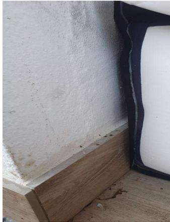
Les plinthes peuvent constituer un obstacle à l'étanchéité du dispositif. Au-delà de 7 mm, le joint ne peut plus assurer l'étanchéité. Il est donc fortement conseillé soit de prévoir un matériel permettant de combler ce déficit, soit de mettre une bande de joint supplémentaire.
